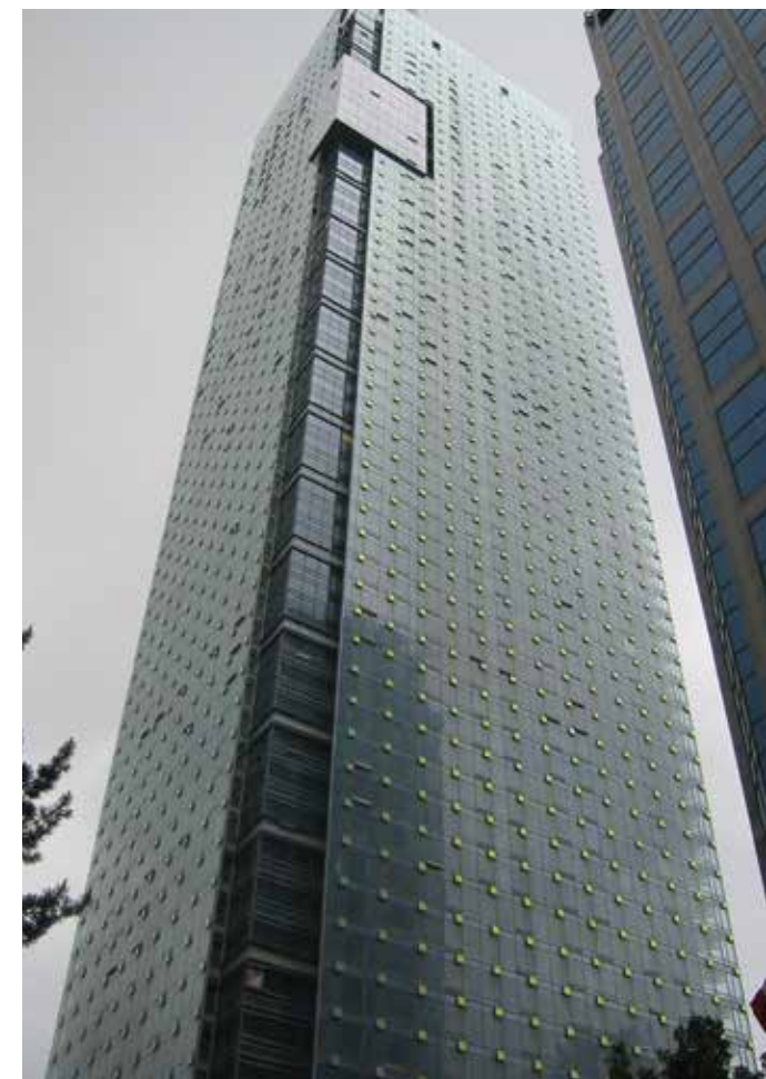
Conçu par James K. M. Cheng Architects Inc., le Living Shangri-La, cet hôtel riverain visuellement impressionnant de Vancouver, a été construit avec les matériaux isolants spécifiés CURTAINROCK MD et ROXUL SAFE MC .
