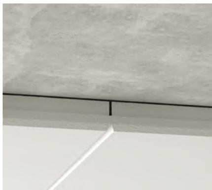
**DMT (Montage direct)** L'option Montage direct est utilisée pour coller les panneaux directement sur la structure ou sur une surface de plafond existante à l'aide d'un adhésif recommandé.
